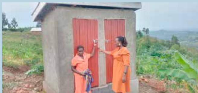
Latrin og bad som også hører til de nybyggede huse.
