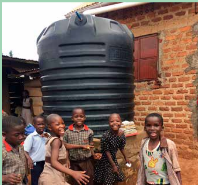
Vandtank doneret til skole, der manglede vand.
